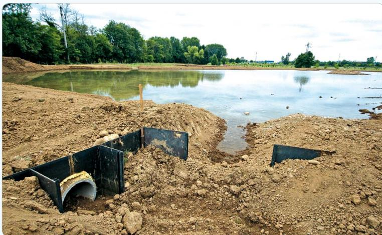
**Foto 3.** Particolare delle paratie in acciaio (foto M. Chemollo).
